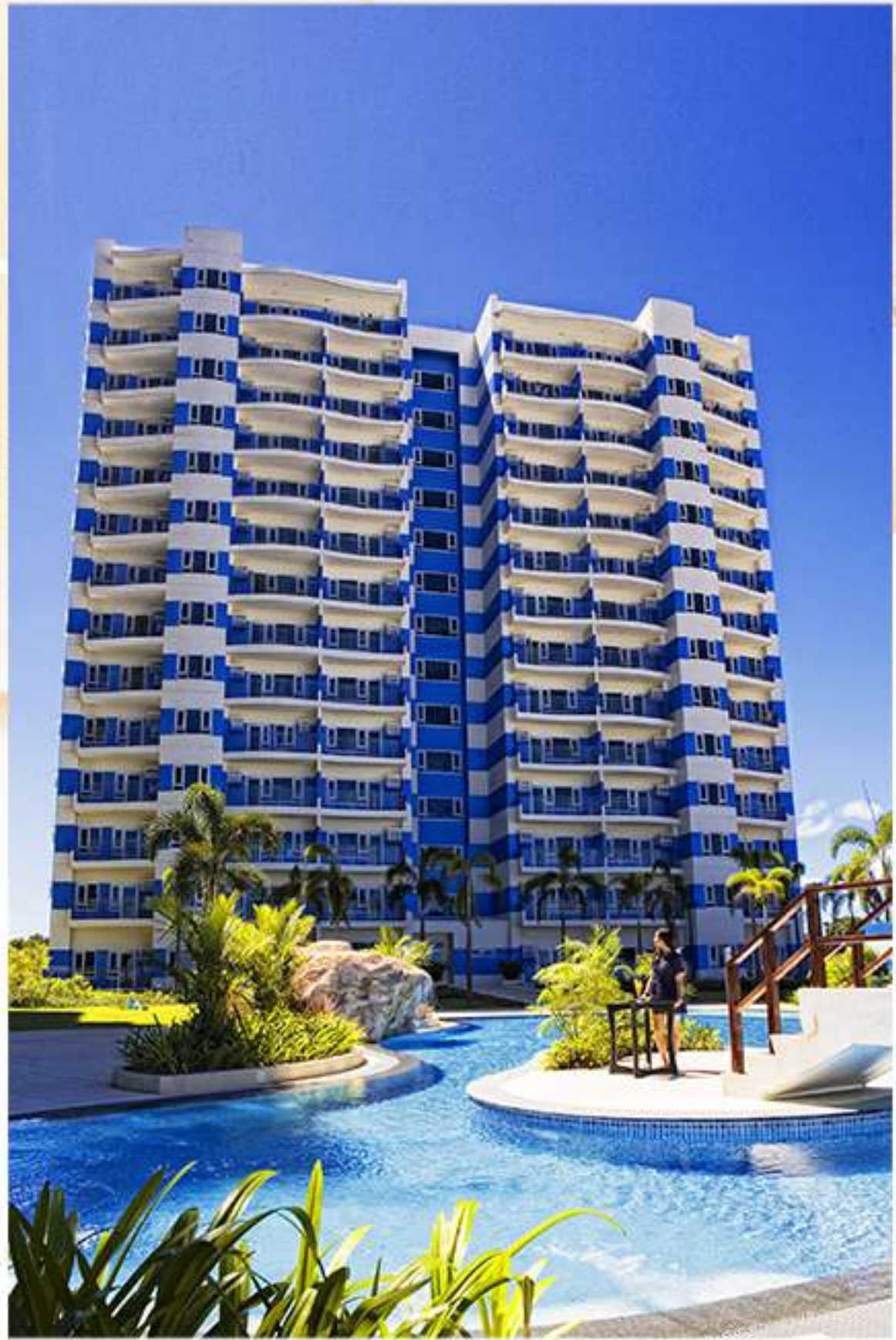
Actual Photo of AmiSa Tower A
