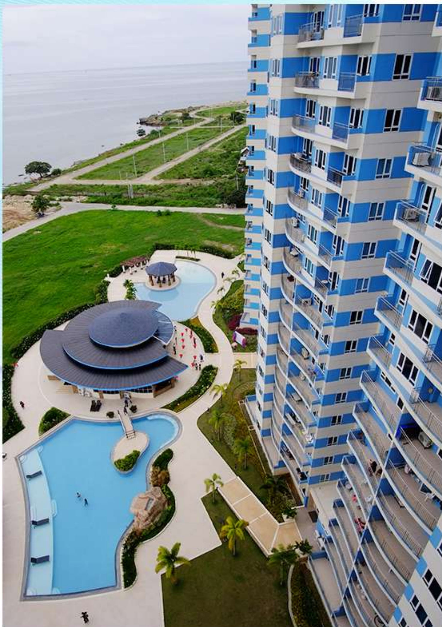
Actual Photo of AmiSa Towers
