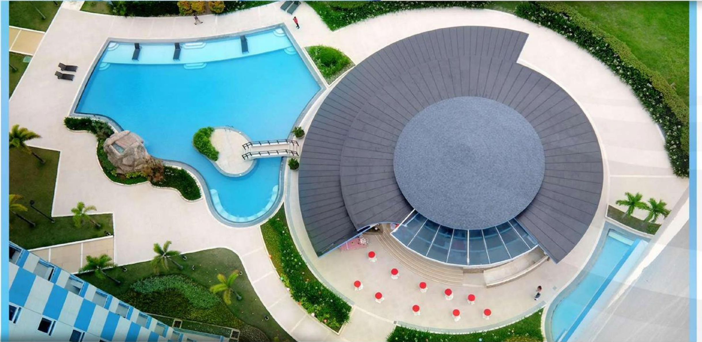
Actual photo of the Function Room
